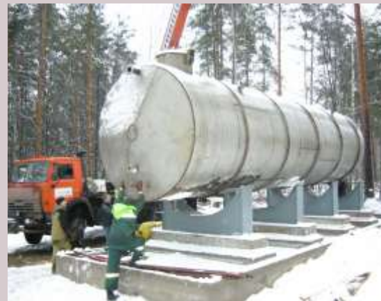
Монтаж насосной и баки запаса сиважной воды на базе «Уют» ГУП «ТЭК СПб»
