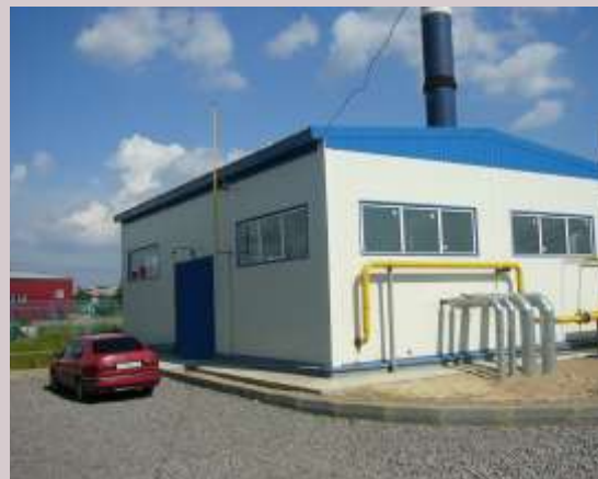
Водогрейная котельная ООО «Морепродукт», г. Всеволожск
